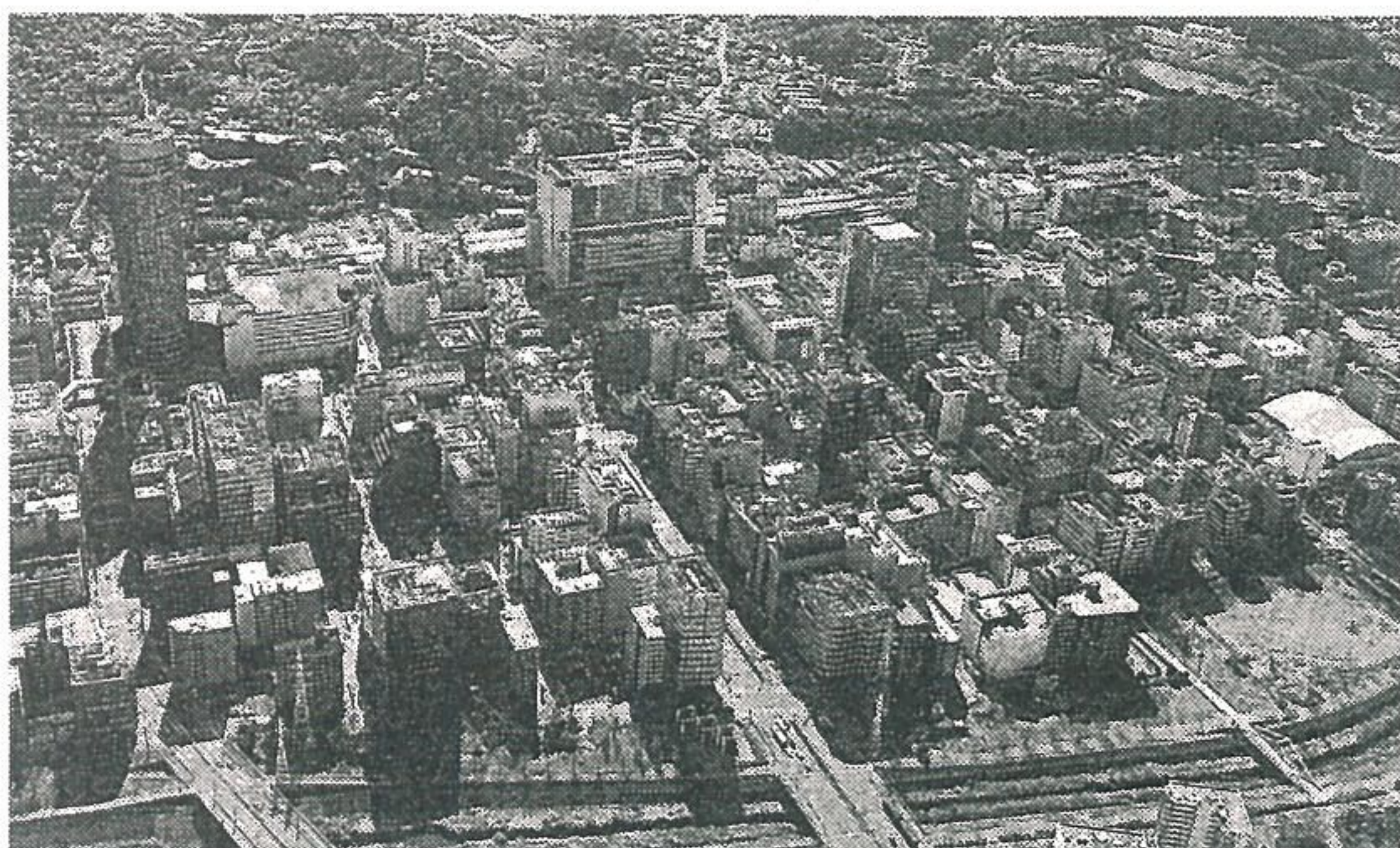
新横浜駅前には今後1、2年で十数棟の新築大型ビルが完成する。写真中央奥が近く完成する駅ビル
